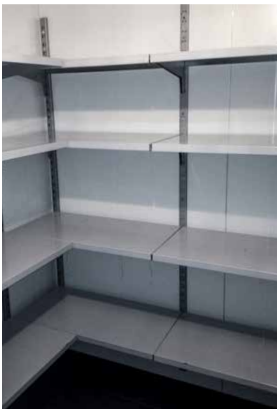
Rostfria vägghyllor med skruvade väggskenor (OBS Hyllorna på fotot har fortfarande sin skyddsplats på)
